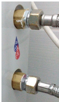
Slika 1: Priklučenje dozatora
