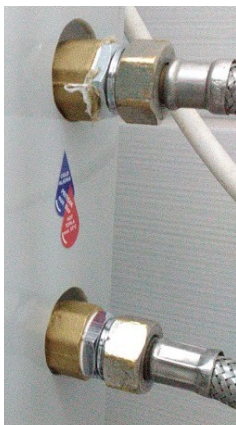
Slika 1: Priključenje dozatora P201, P211
